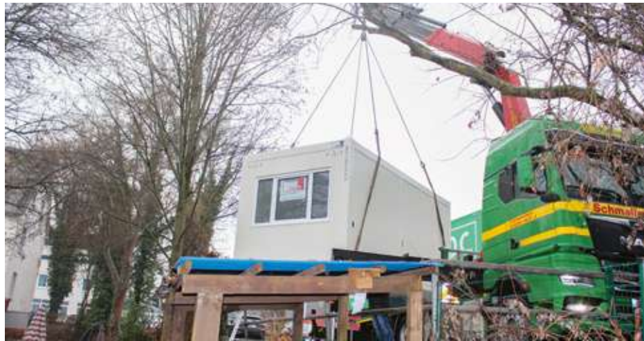
Per Ladekran und an vier Ketten befestigt schwebt der Raumcontainer über den Zaun auf dem Innenhof des Café Patchwork ein.
