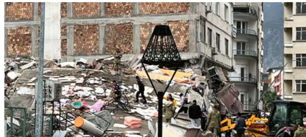
Wo anfangen? Nach der Katastrophe werden die Aufbauarbeiten noch lange dauern.
